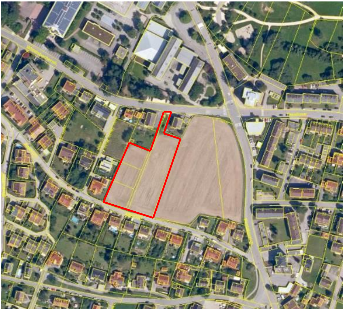
Außenbereich im Innenbereich (WA „Albertstraße“)
