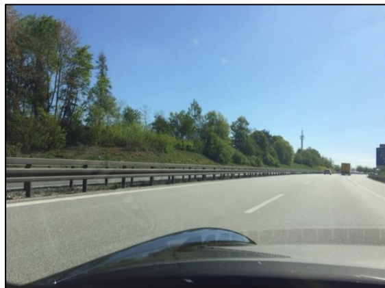
Abb. 2 Blick von Südwesten in Fahrtrichtung Passau
